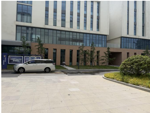
医药实验动物中心东侧校区道路、基础实验楼
