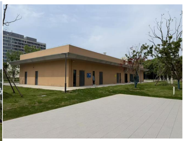
医药实验动物中心南侧实验废弃物暂存间
